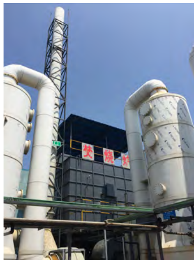
图 5.6 RT0 焚烧炉及二级碱吸收装置
