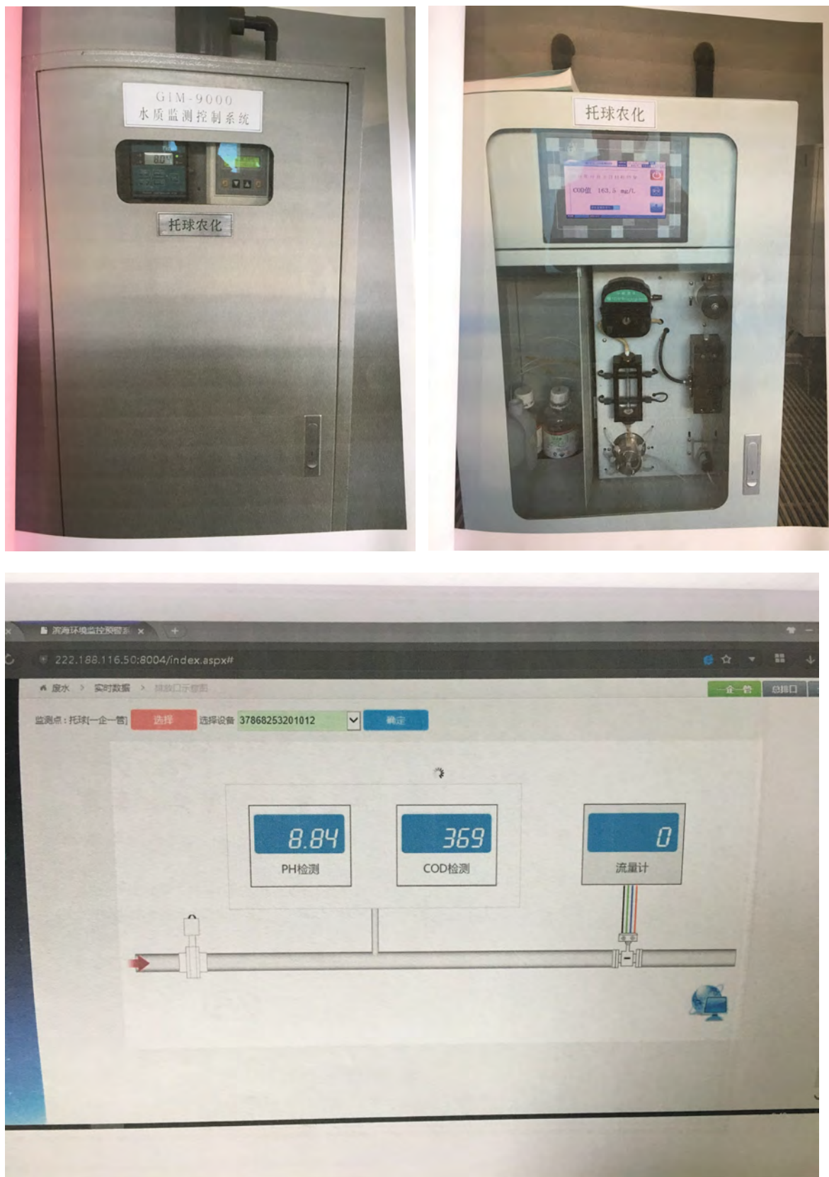
图 5.3 项目废水在线监测仪器
