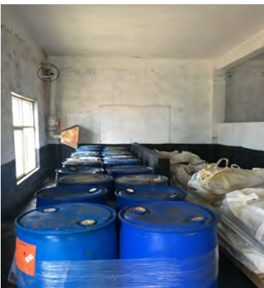
图 5.15 固废仓库内监控
