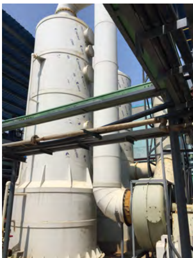
图 5.6 RT0 焚烧炉及二级碱吸收装置
